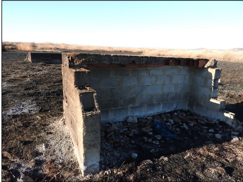
Figura 212. Restos de construcciones
