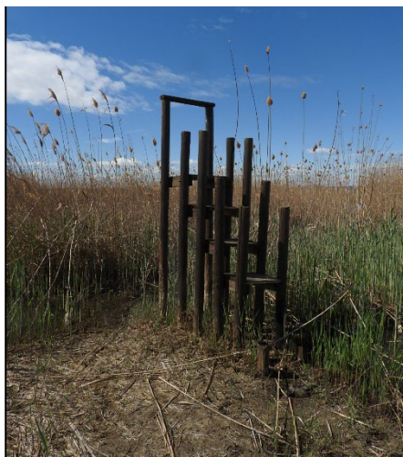
Figura 192. Mirador 6 a sustituir (numeración según figura 188)
