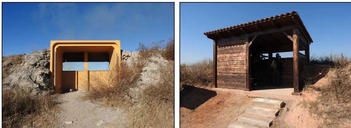
Figura 189. A la izquierda, observatorio de hormigón prefabricado (2), a la derecha observatorio de madera (3) (numeración según figura 188)
