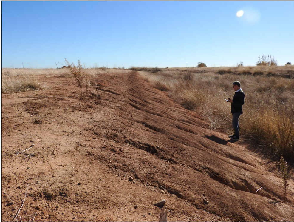
Figura 120. Estado actual de la gola
