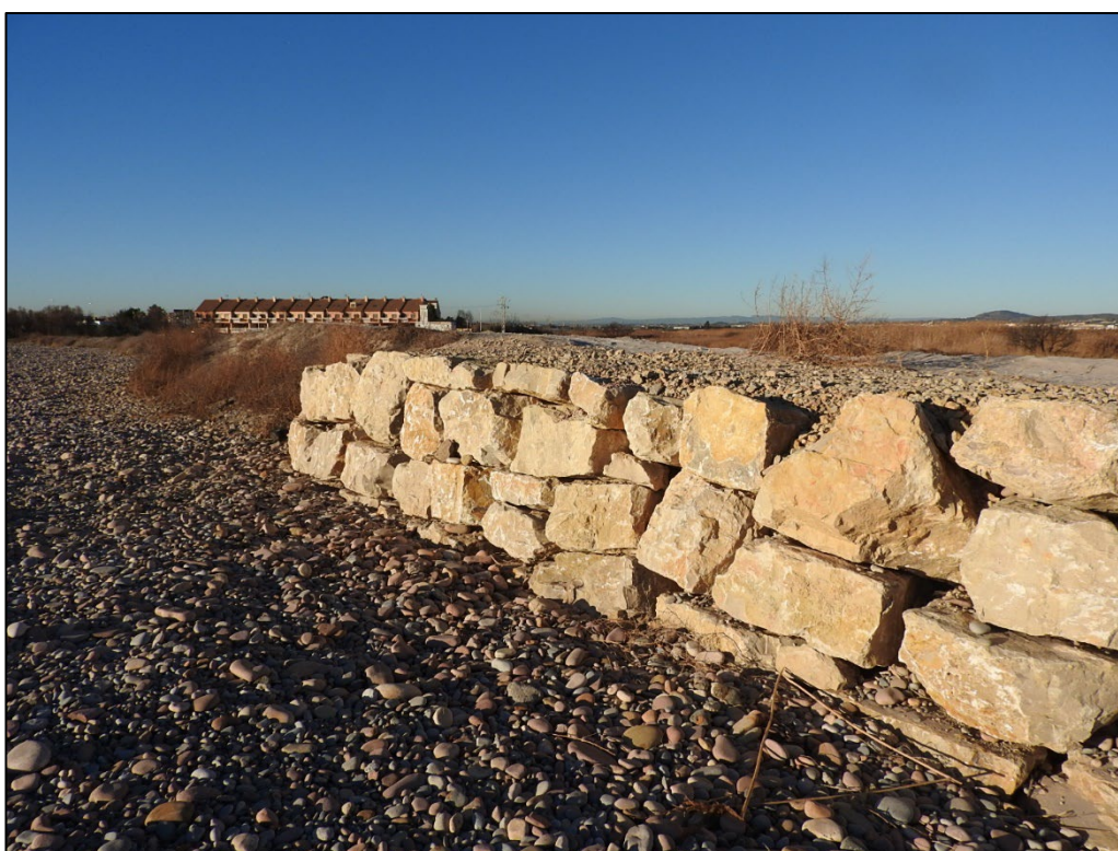
Figura 10. Restauración y protección de la mota litoral mediante escollera
